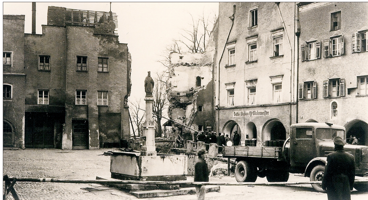
Nach dem Einsturz klaffte ein großes Loch in der Stadtplatz-Silhouette. – Foto: Archiv Grätzl
